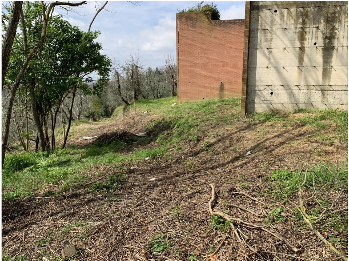
Foto 3 - vista della pista all'angolo sud-est del parcheggio esistente
