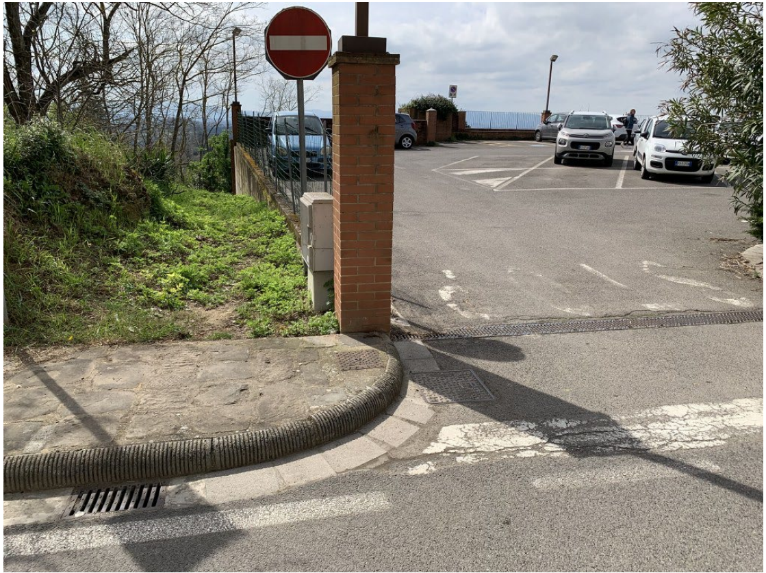
Foto 1 - vista del punto di ingresso della nuova strada
