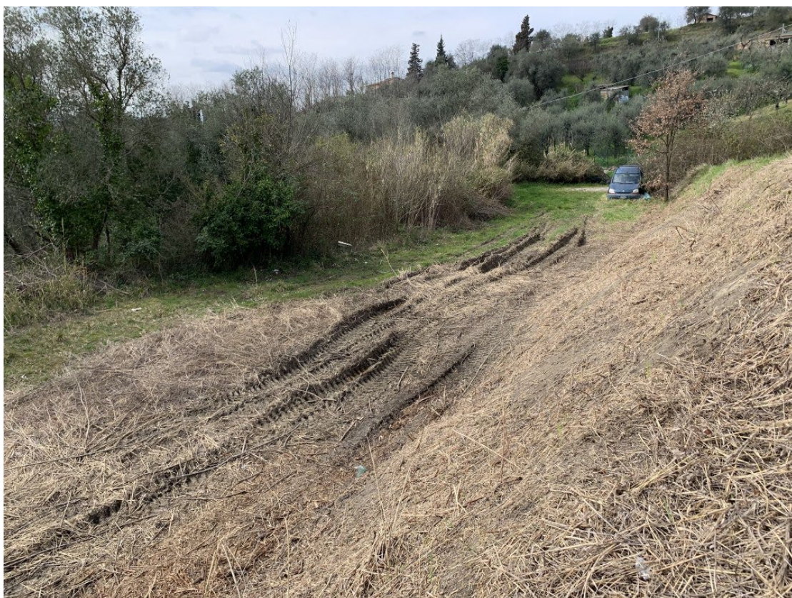
Foto 12 - vista della pista in prossimità dell'innesto con Via Di Carbonaia
