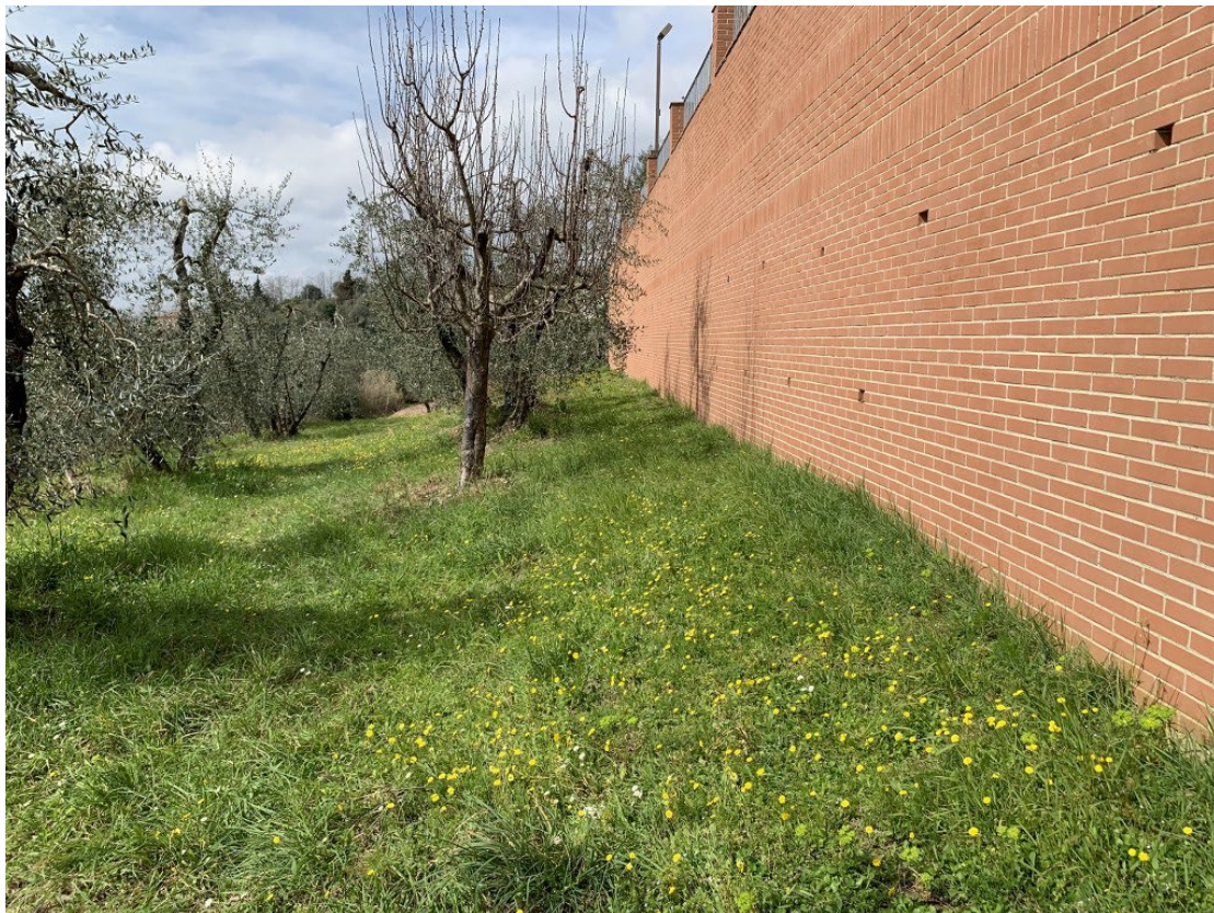
Foto 7- vista del pianoro sul lato sud del parcheggio esistente
