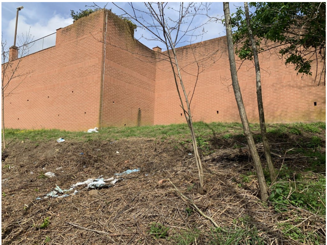
Foto 4 - vista del muro sud- est del parcheggio esistente
