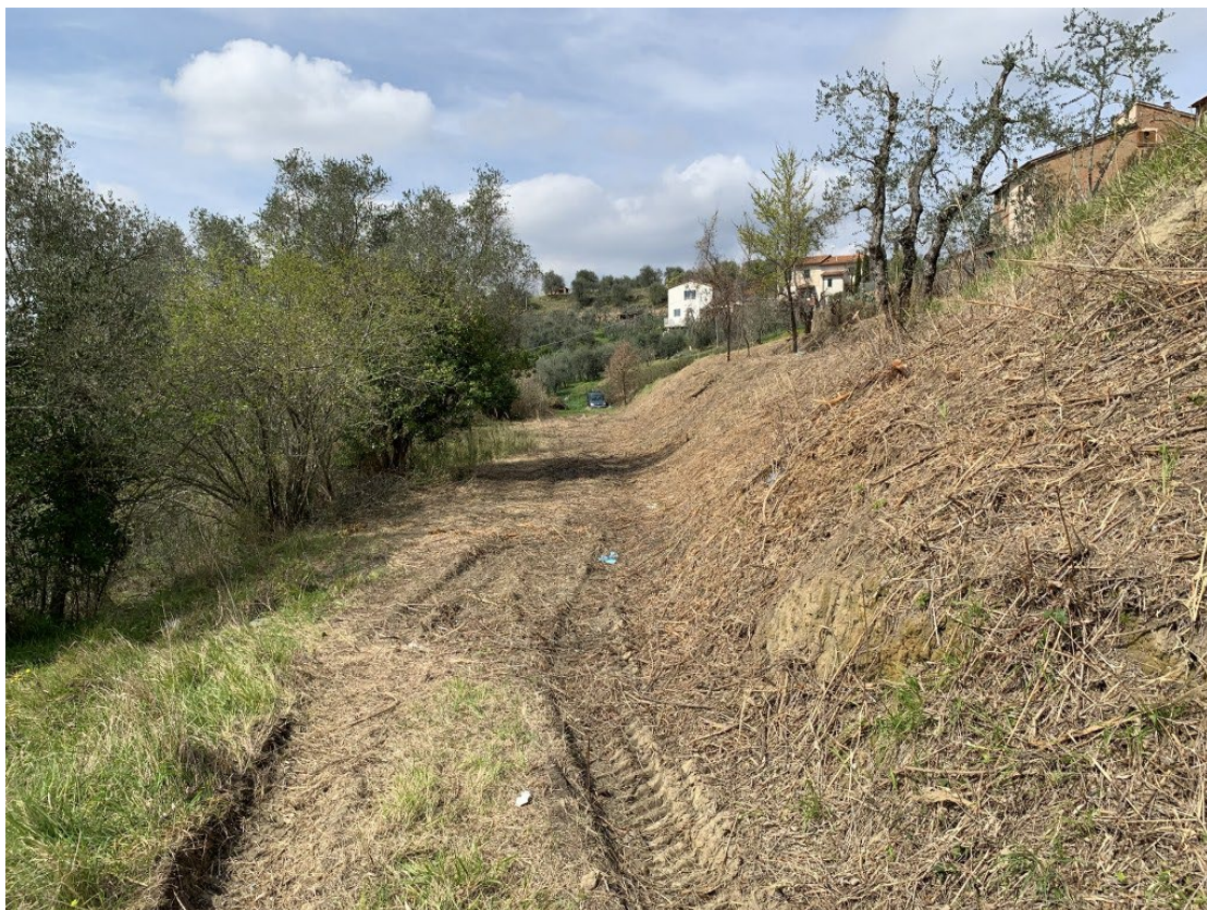
Foto 15 - vista della pista in prossimità dell'innesto con Via Di Carbonaia
