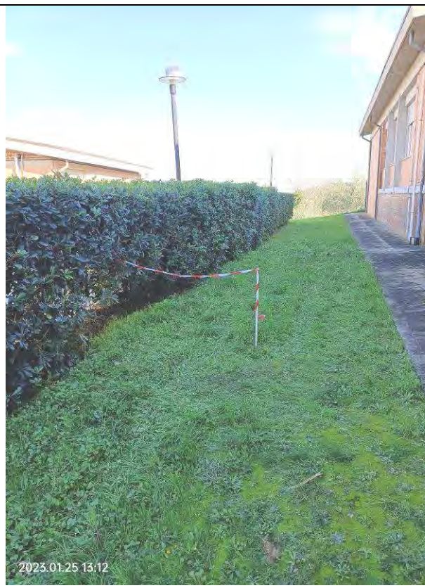
Piezometro in foro penetrometria P3
